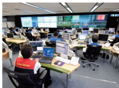
監視・保守・運用の司令塔である「FSC24®」
